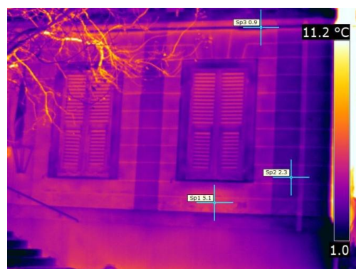
Figura 8.1 – Particolare della muratura perimetrale dell’edificio nella parte basamentale
