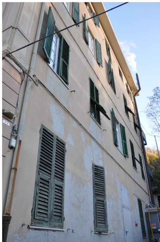
Figura 1.1 - Vista della facciata sud con le uscite secondarie del refettorio
