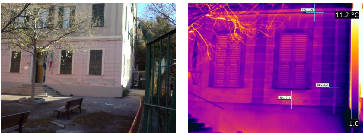
Figura 4.3 – Rilievo termografico della parete del fronte principale nella zona basamentale
